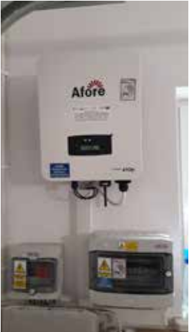
Fot. z zasobów Urzędu Miejskiego w Dynowie Falownik wraz z zabezpieczeniami elektrycznymi wewnątrz budynku
