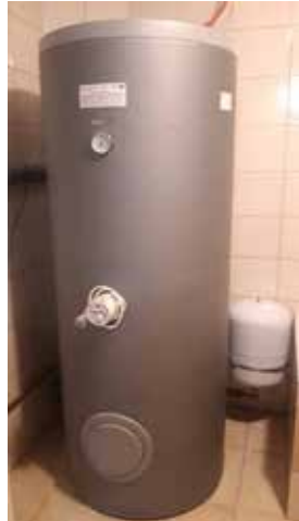
Fot. z zasobów Urzędu Miejskiego w Dynowie Zasobnik ciepłej wody użytkowej kolektorów słonecznych wewnątrz budynku
