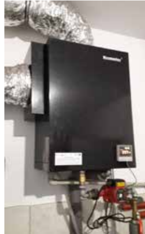
Fot. z zasobów Urzędu Miejskiego w Dynowie Pompa ciepła ciepłej wody użytkowej wewnątrz budynku
