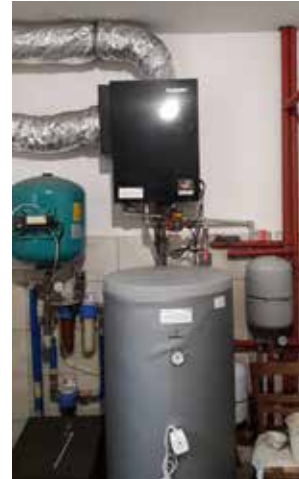
Fot. z zasobów Urzędu Miejskiego w Dynowie Pompa ciepła wraz z zasobnikiem ciepłej wody użytkowej wewnątrz budynku
